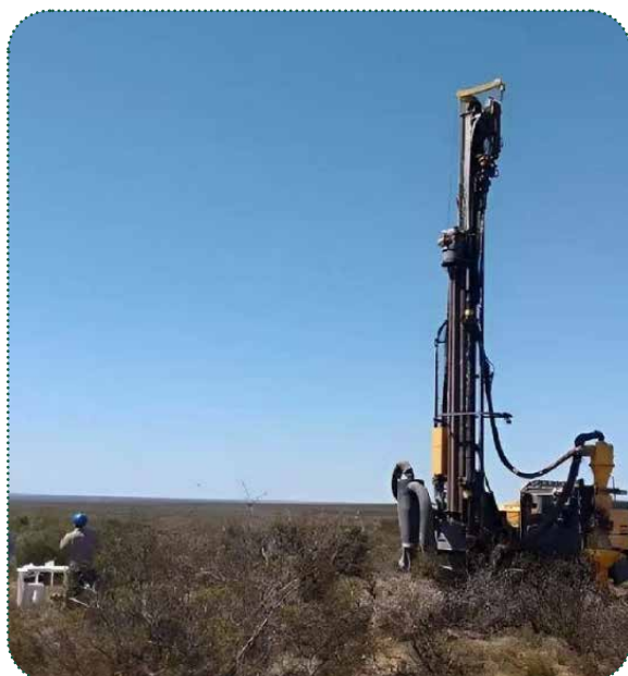
Avanza el proyecto minero Pukaqaqa en Huancavelica. Foto: Tecnología minera
